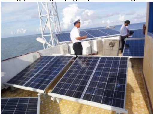
Hình 1. Lắp đặt tấm pin trên tàu cá [3]. Hình 2. Lắp đặt tấm pin nằm trên mặt boong [1].
